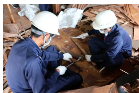
【建設現場での作業】
