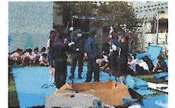
仮設トイレ設置
